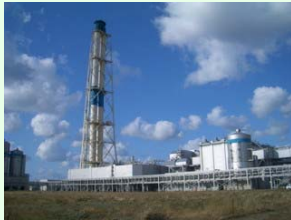
東北電力㈱能代火力発電所
