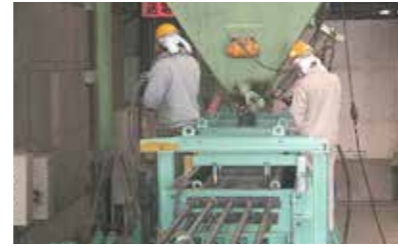
③コンクリート打設
