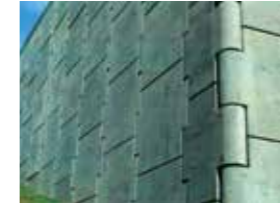
●テールアルメ工法
