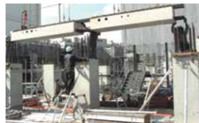
⑧梁部材取付
