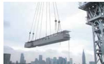
⑥部材吊上げ
