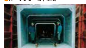
●ボックスベアリング横引き工法
