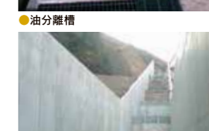
●大型PCaブロック(排水路)
