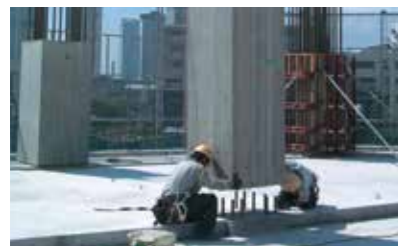
⑦柱部材取付
