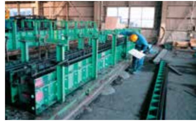
②打設前検査
