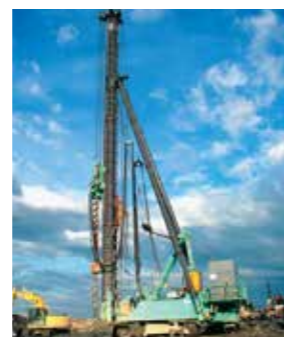
●プレボーリング拡大根固め工法
