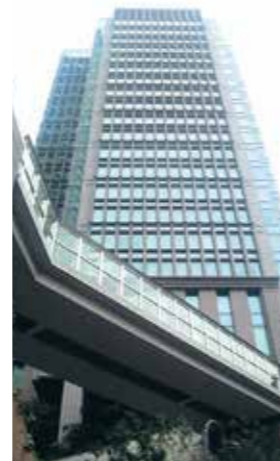
●ダクトル製連絡通路
