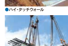
●建築用部材(柱)
