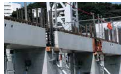
⑨柱・梁部材取付
