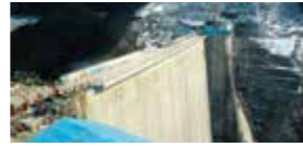
●ダム天端張出床版
