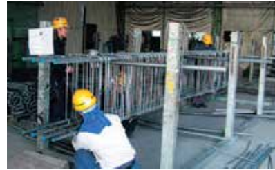
①鉄筋組立
