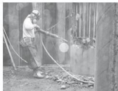
●杭頭部はつり
