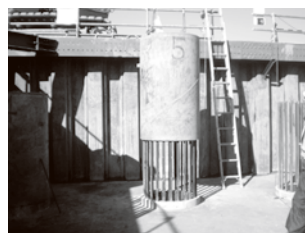
●杭頭部引き抜き
