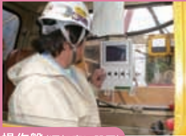
操作盤 (運転席に設置)
