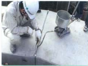
頂版から注入
