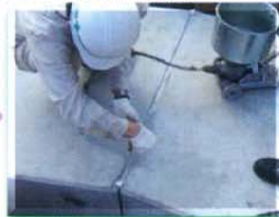
上部より頂板天端部へ注入
