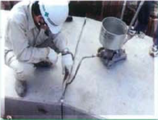
注入口より側壁部・底板部へ注入
