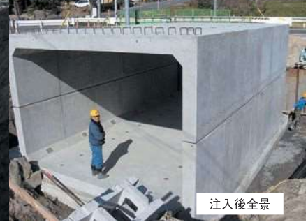
グラウト注入
