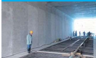
東北地方整備局仙台河川国道事務所 宮城県登米市 6500B×5300H(3分割底板現場打ち)延長36.3m
