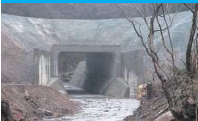
北陸農政局佐渡農業水利事業所 新潟県佐渡市 6200B×4900H(3分割底板現場打ち)延長24.1m
