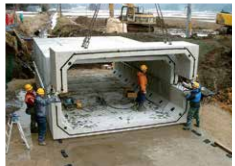
施工中のPCaボックスカルバート
