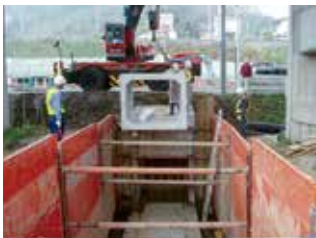
製品の吊り下ろし
