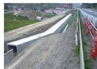
施工中のPCaボックスカルバート
