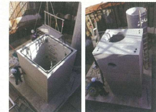
下部現場打の上部工
