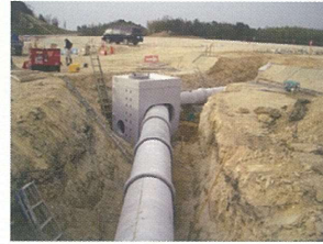
ヒューム管接続
