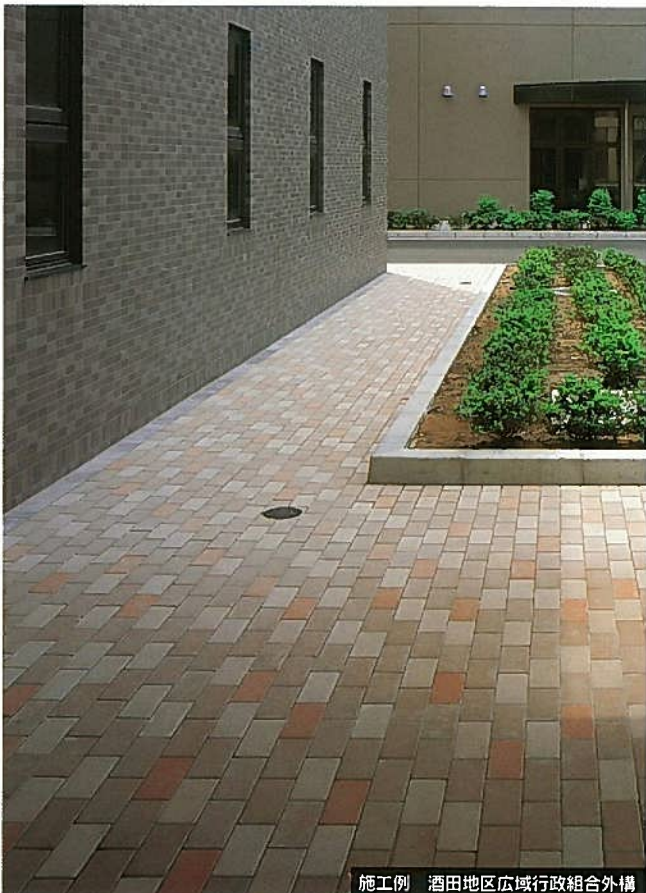
施工例 酒田地区広域行政組合外構
