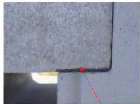
防音用緩衝材は長年にわたり全国で使用され、多くの実績があり、耐久性が実証されている材料(PVC製)を使用しています。
