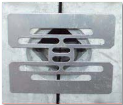
排水性舗装対応排水孔
