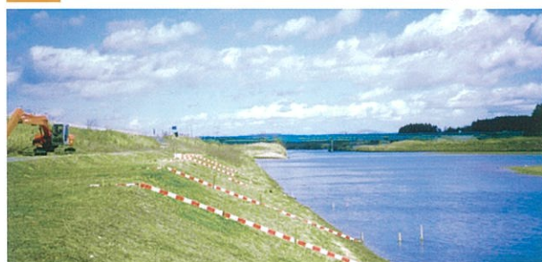
床堀り、法面整形を行います。できるだけ平坦に仕上げてください。
