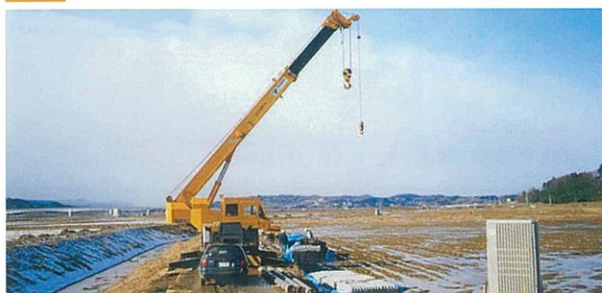
敷設計画に従い、敷設箇所付近に仮置きします。
