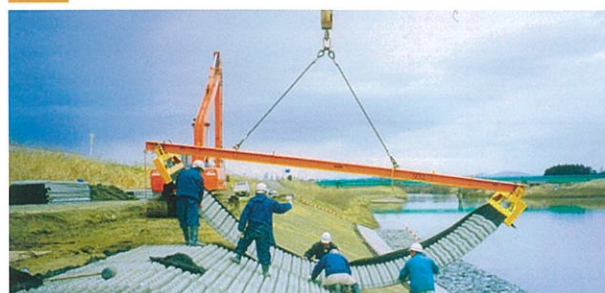
専用吊金具(クランプ)を用いて所定の位置に設置します。
