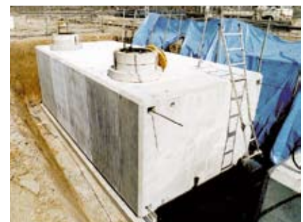
●掘付(吸込投入孔)
