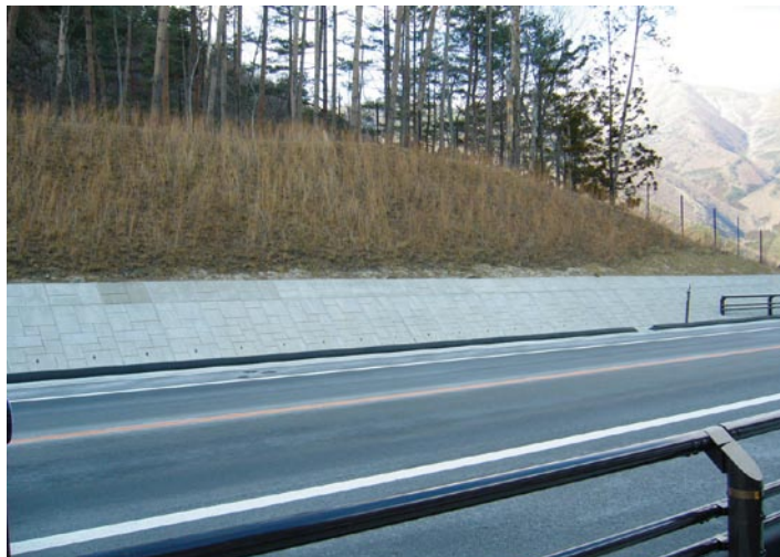
▲岩手県釜石市仙人峠道路
