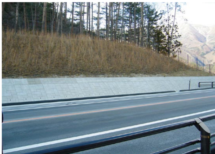
▲岩手県釜石市仙人峠道路
