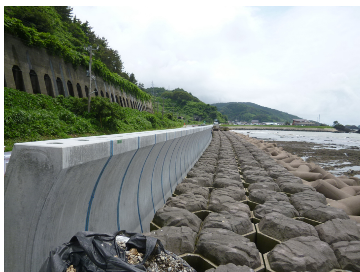
据付完了（仮復旧）海側
