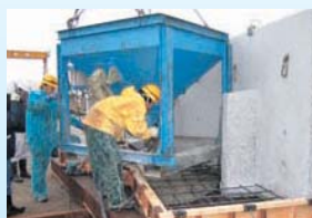
■コンクリート打設
