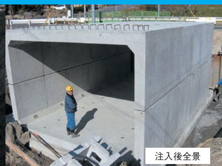
グラウト注入
