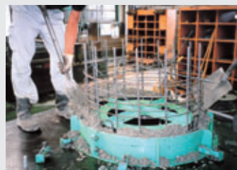
(3) コンクリート打設状況
