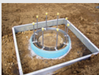
(2') PCリング下端に、モルタルを設けた場合
