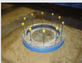
(3) コンクリート打設後
