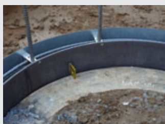
(1) 杭頭のPCリング型枠を設置後定着筋をセット
