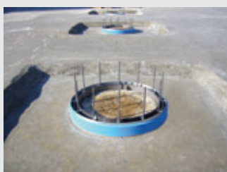
(2) PCリング下端に、発泡ポリエチレンを設けた場合
