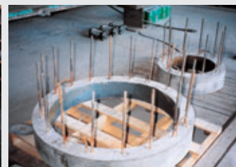
(4) 型枠脱型後
