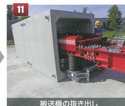
搬送機の抜き出し
