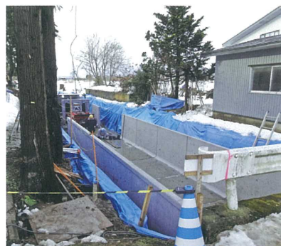
大型水路の施工状況 (某幹線用水路改修工事)
