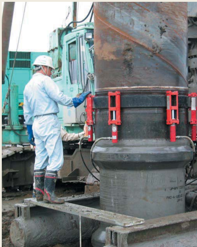
●内リングと外リングの嵌合〈杭径1100mm〉
