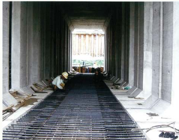
4 底板現場打ち部の配筋
