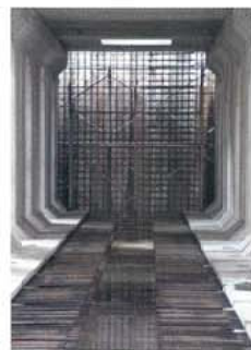
●現場打ち端壁
