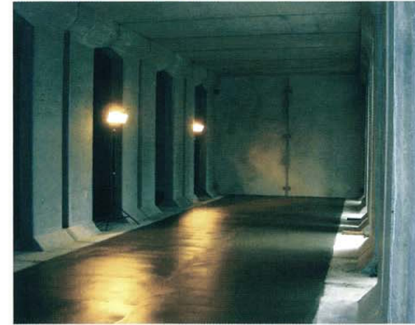
6 コンクリート打設完了
