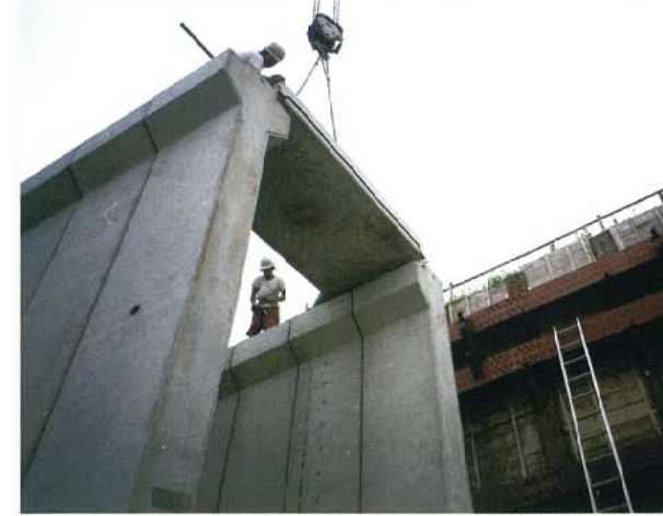
2 スラブの据付
