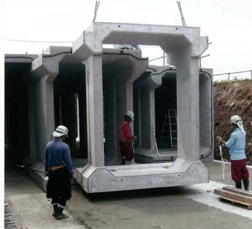
1 ボックス型タイプ ブロックの据付
