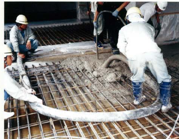
5 底板部コンクリート打設
