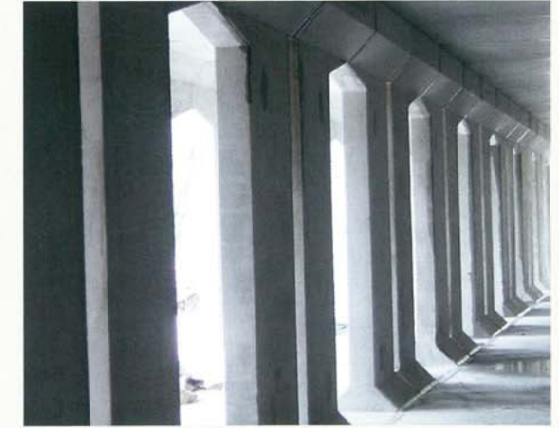
7 完成した遊水池の内部
