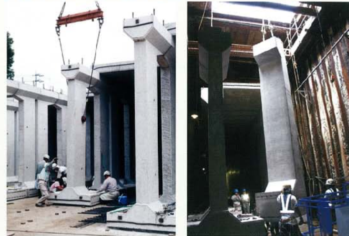
スタンド型タイプ ブロックの据付
