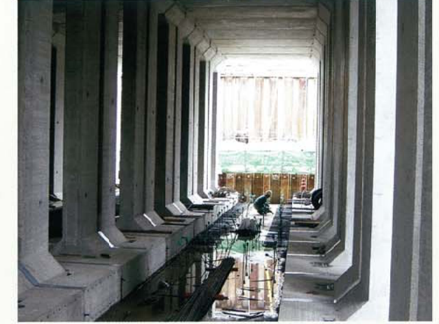
3 プレキャストブロックの据付完了
