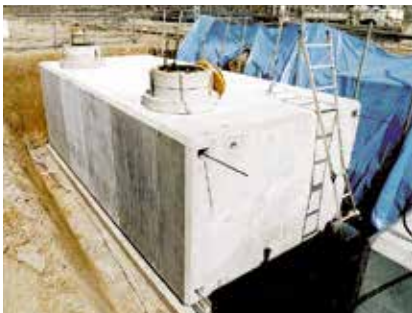
● 据付 (吸着投入孔)
